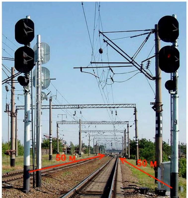
Допускается эксплуатация входных светофоров, ранее установленных на расстоянии **менее 50 м**, но не ближе 15 м от стрелочного перевода. На электрифицированных участках путей входные светофоры, а также сигнальные знаки "Граница станции" должны устанавливаться перед воздушными промежутками (со стороны перегона), отделяющими контактную сеть перегонов от контактной сети станции.
