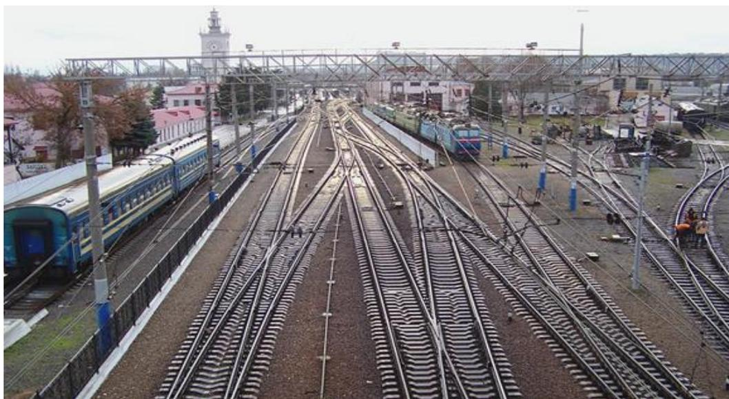
Станции, разъезды и обгонные пункты должны располагаться на горизонтальной площадке. В отдельных случаях допускается расположение их на уклонах - не круче 0,0015, а в трудных топографических условиях проектирования - не круче 0,0025 (Прил. №1 п.4 ПТЭ)
