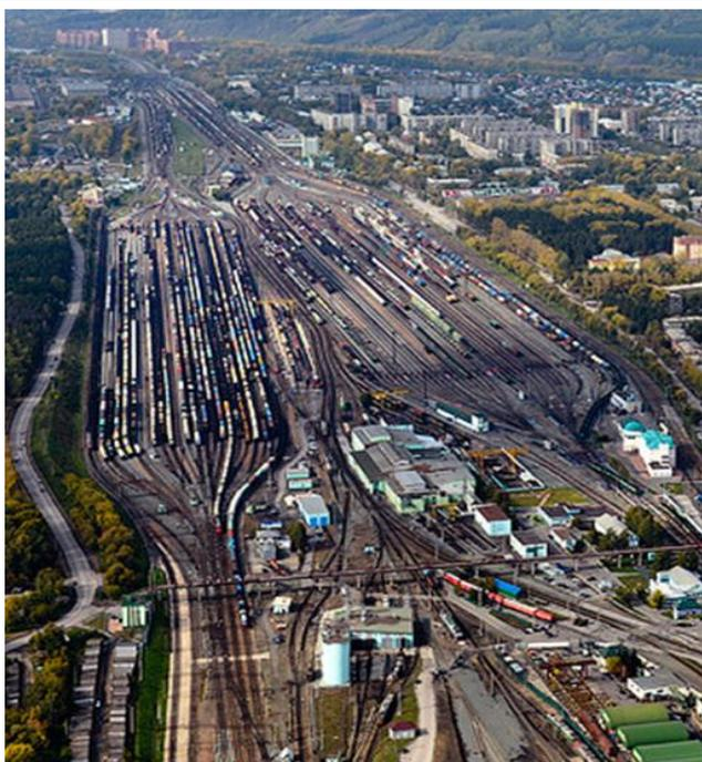
Станции, разъезды и обгонные пункты, а также отдельные парки и вытяжные пути должны располагаться на прямых участках. В трудных условиях допускается размещение их на кривых радиусом - не менее 1500 м. В особо трудных условиях допускается уменьшение радиуса кривой до 600 м, а в горных условиях - до 500 м
